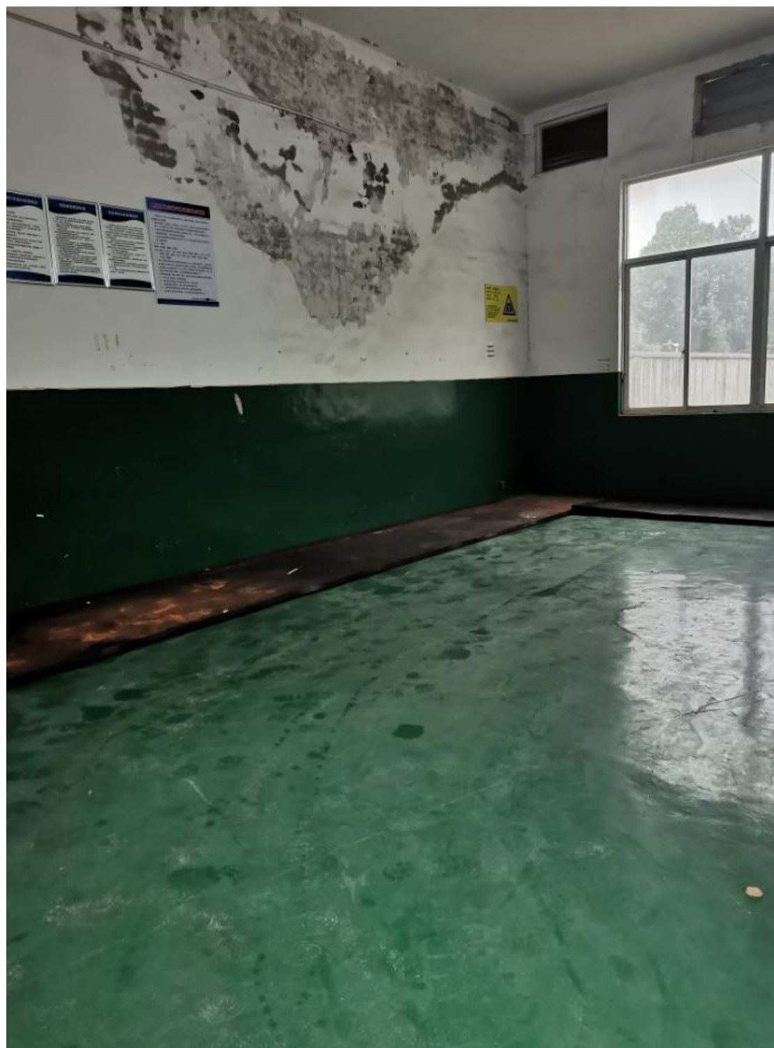
危废仓库内部
