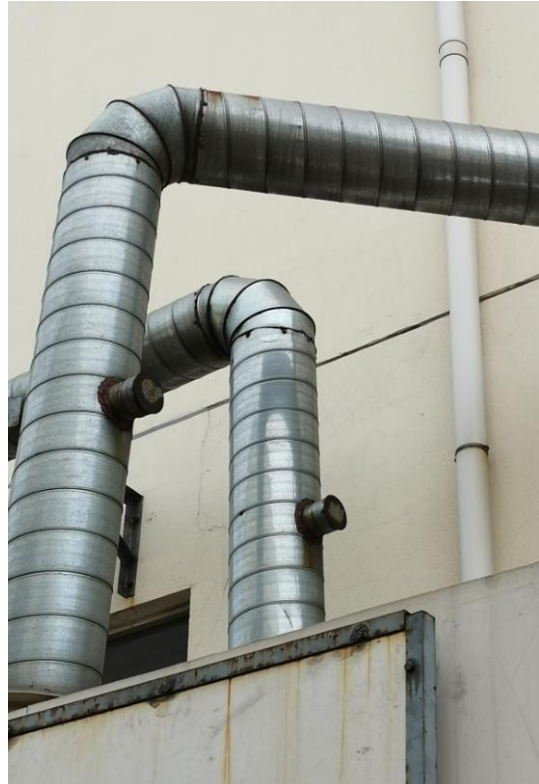
1#排气筒进口检测口
