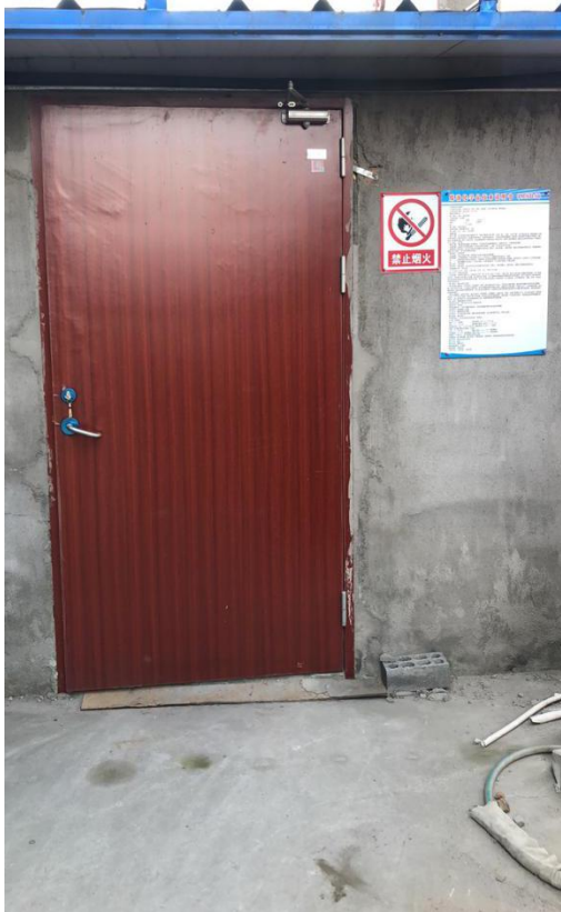
煤油储存区环境风险防范措施
