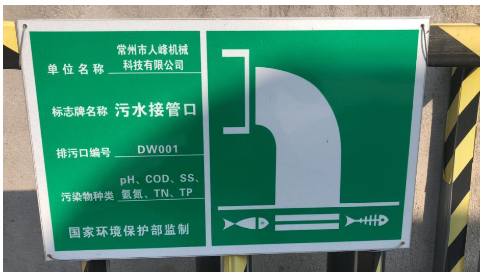
污水排放口现场规范化建设照片
